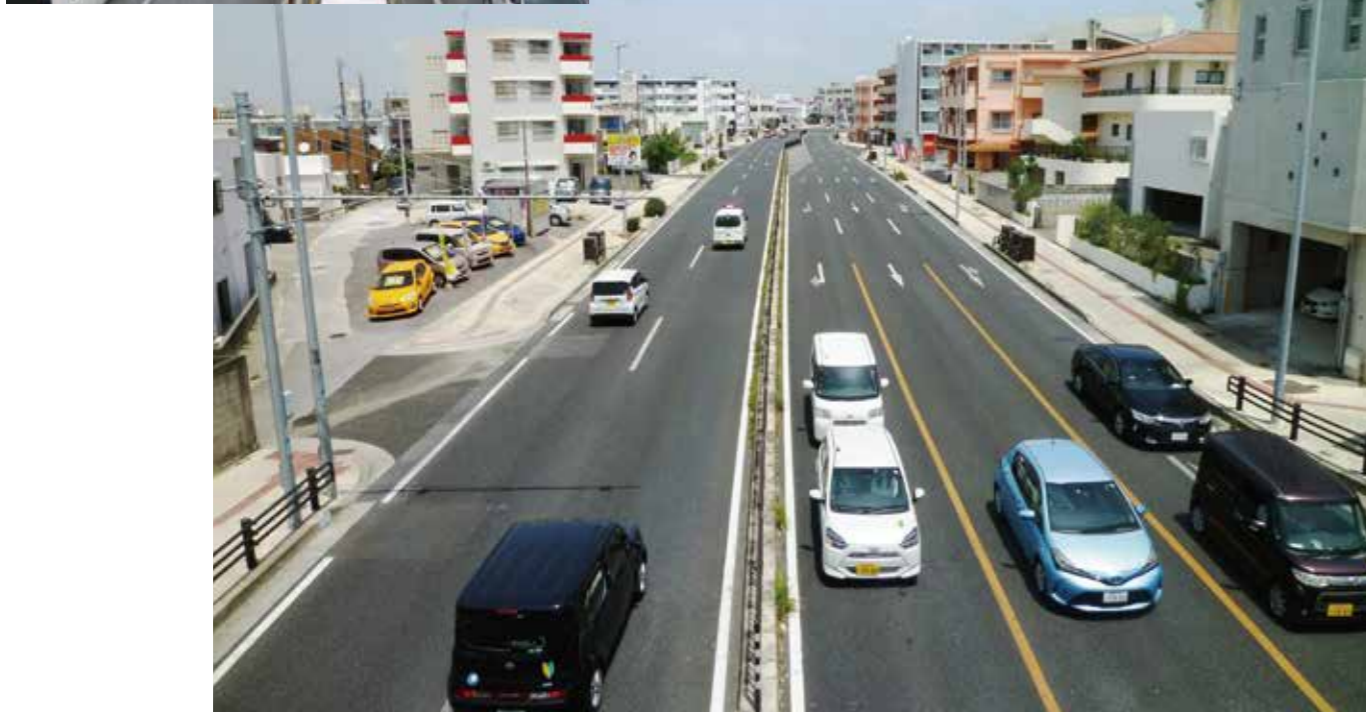
無電柱化の整備事例(国道330号宜野湾市我如古)
