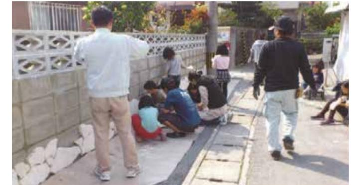
ブロック塀に琉球石灰岩を張り付ける作業
