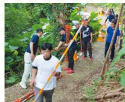
仮設資材の設置
